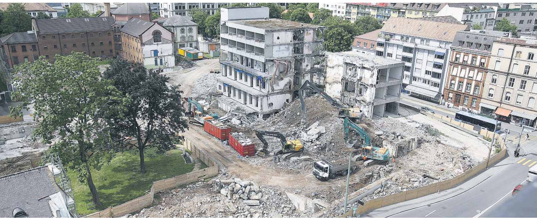
Das Universitäts-Kinderspital ist eine Baustelle – auch organisatorisch: Das Berechnungsmodell wird völlig umgestellt.
